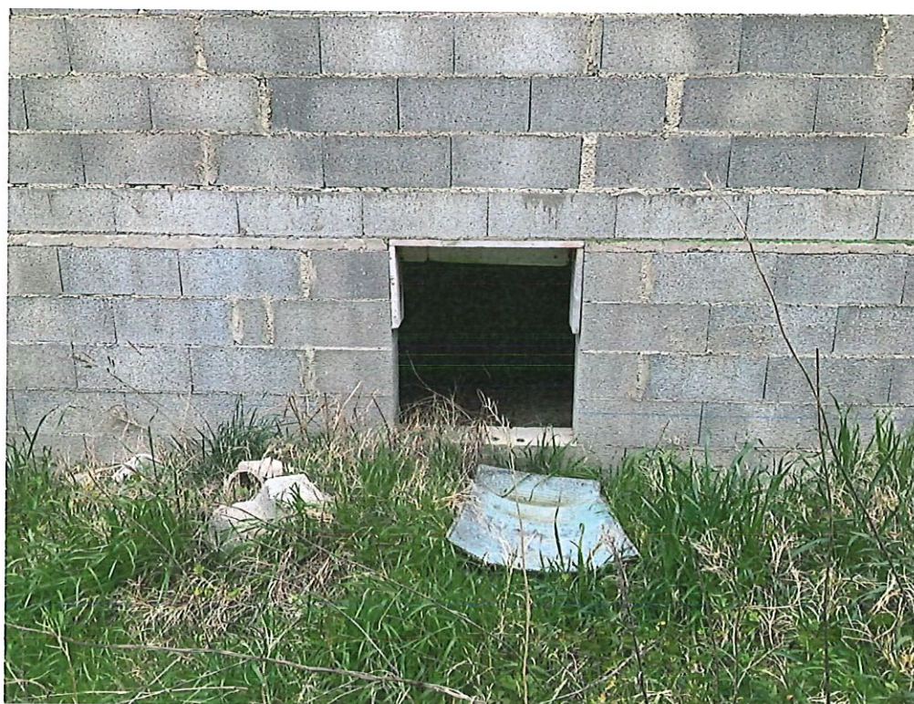
7.Ouverture du Vide Sanitaire
