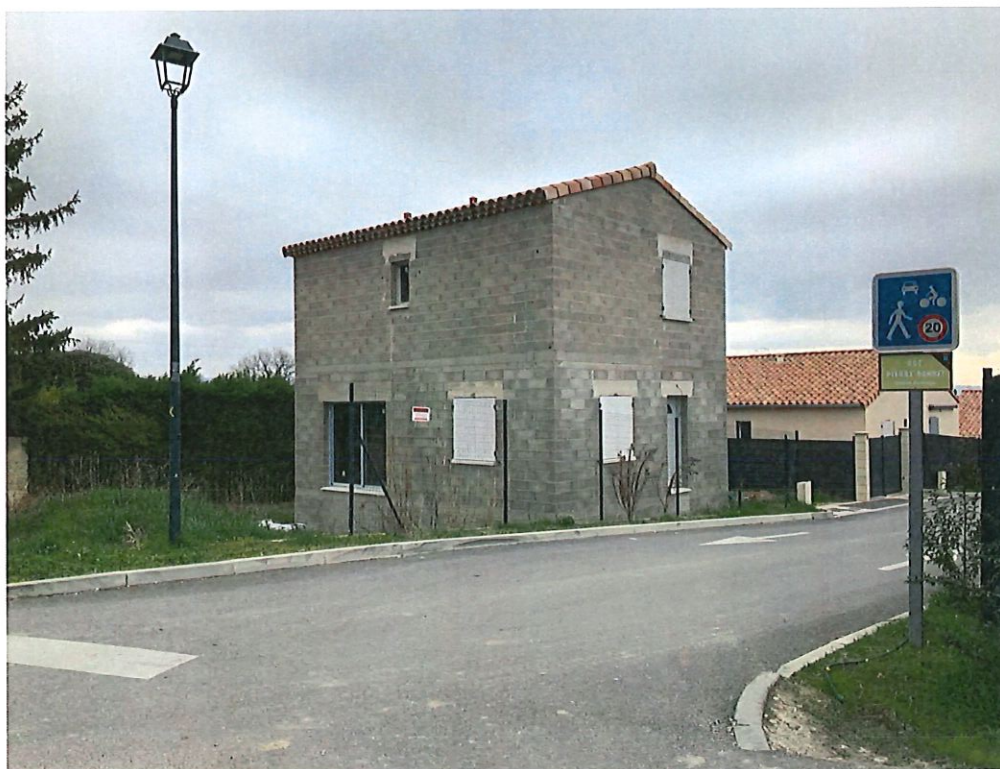
4. Vue depuis le chemin de Crillon
